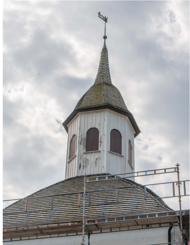
Spåntaken på tornhuven och lanterninen var i gott skick men det var dags för underhåll. Lanterninens fasadpanel hade vissa rötskador och färgen flagnade.
