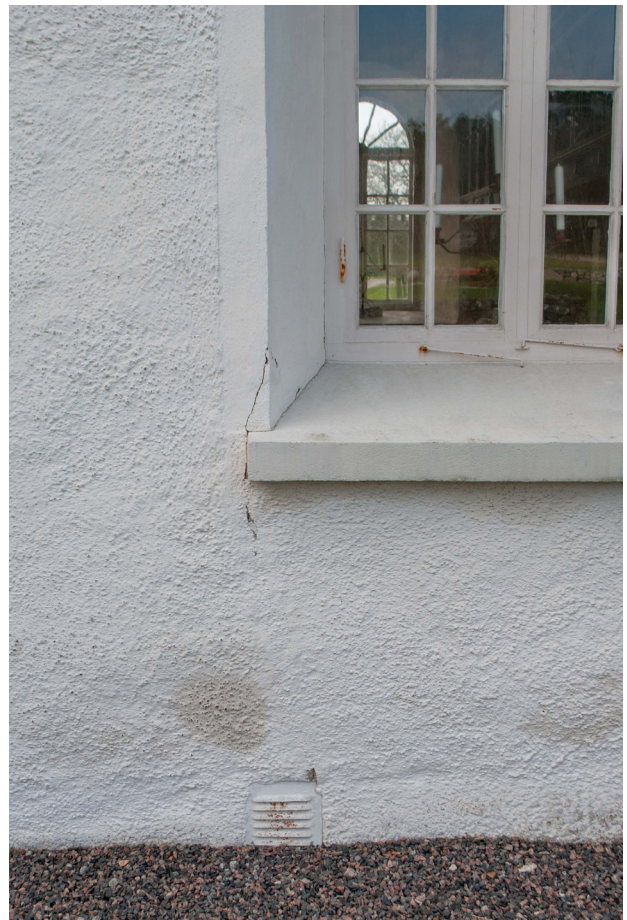
Kyrkan före och under renoveringen. Det fanns några sprickor i fasaden, framför allt runt fönster och luckor.
