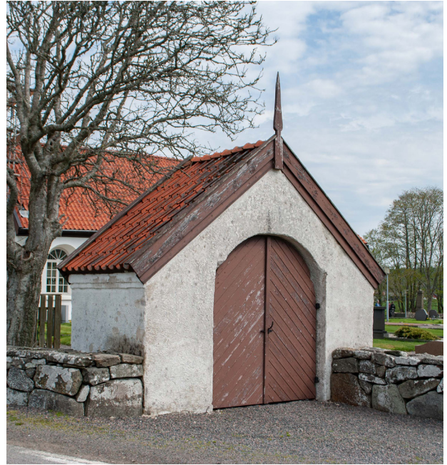
Den södra stigluckan innan renoveringen. Färgen flagnade på port och vindskivor liksom på putsfasaden.
