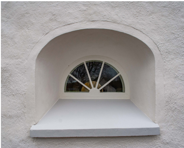
Fönster i vapenhuset, vilket ligger i tornet, efter renoveringen.
