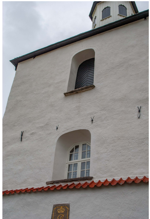
Fasaden på tornet efter renoveringen.
