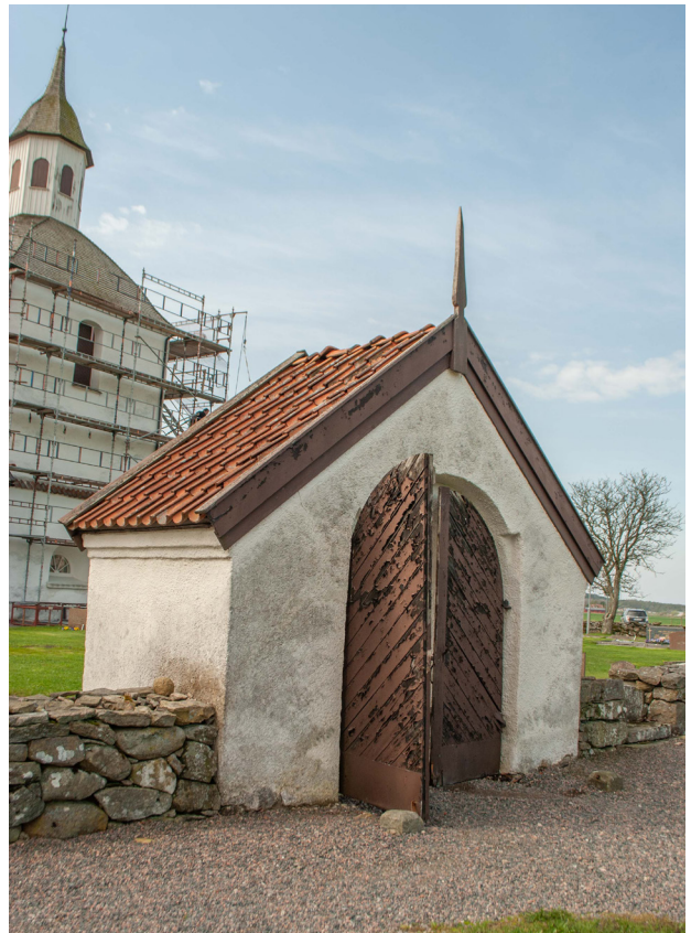
Den norra stigluckan innan renoveringen. Portarna var i mycket dåligt skick.
