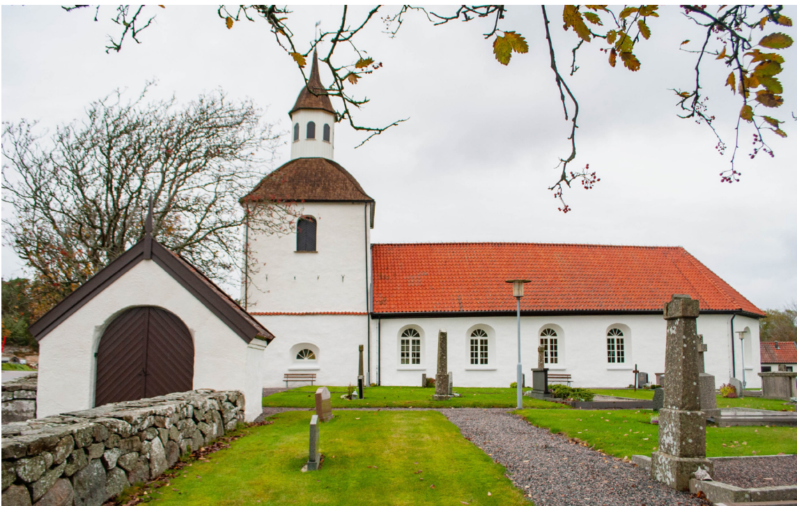
Kyrkan och den södra stigporten efter renoveringen.
