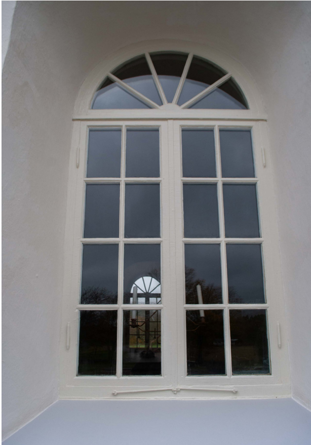
Fönstren har rengjorts och målats om. Ovan ett av fönstren i långhuset.
