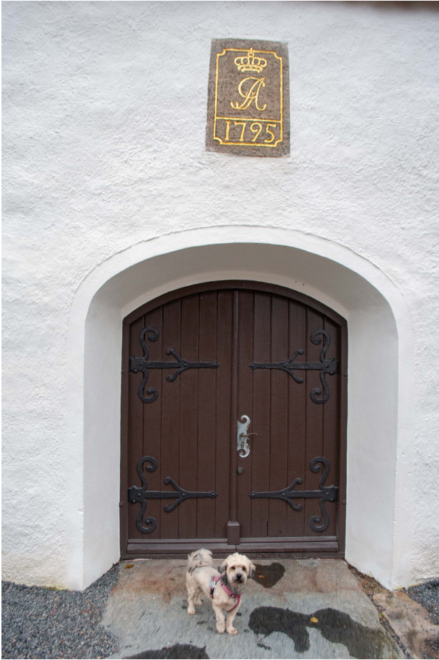
Ovan: Västporten i tornet har målats med likadan brun linoljefärg som tidigare. Till höger: Portalen på södra långhusväggen är målad i vitt som tidigare. Under tegeltaket skymtar den nymålade takfoten.
