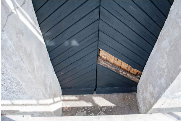
En bräda byttes i ljudluckan mot söder. I övrigt räckte det med ommålning.
