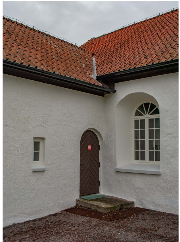
Även fönstren och dörren i sakristian har målats.
