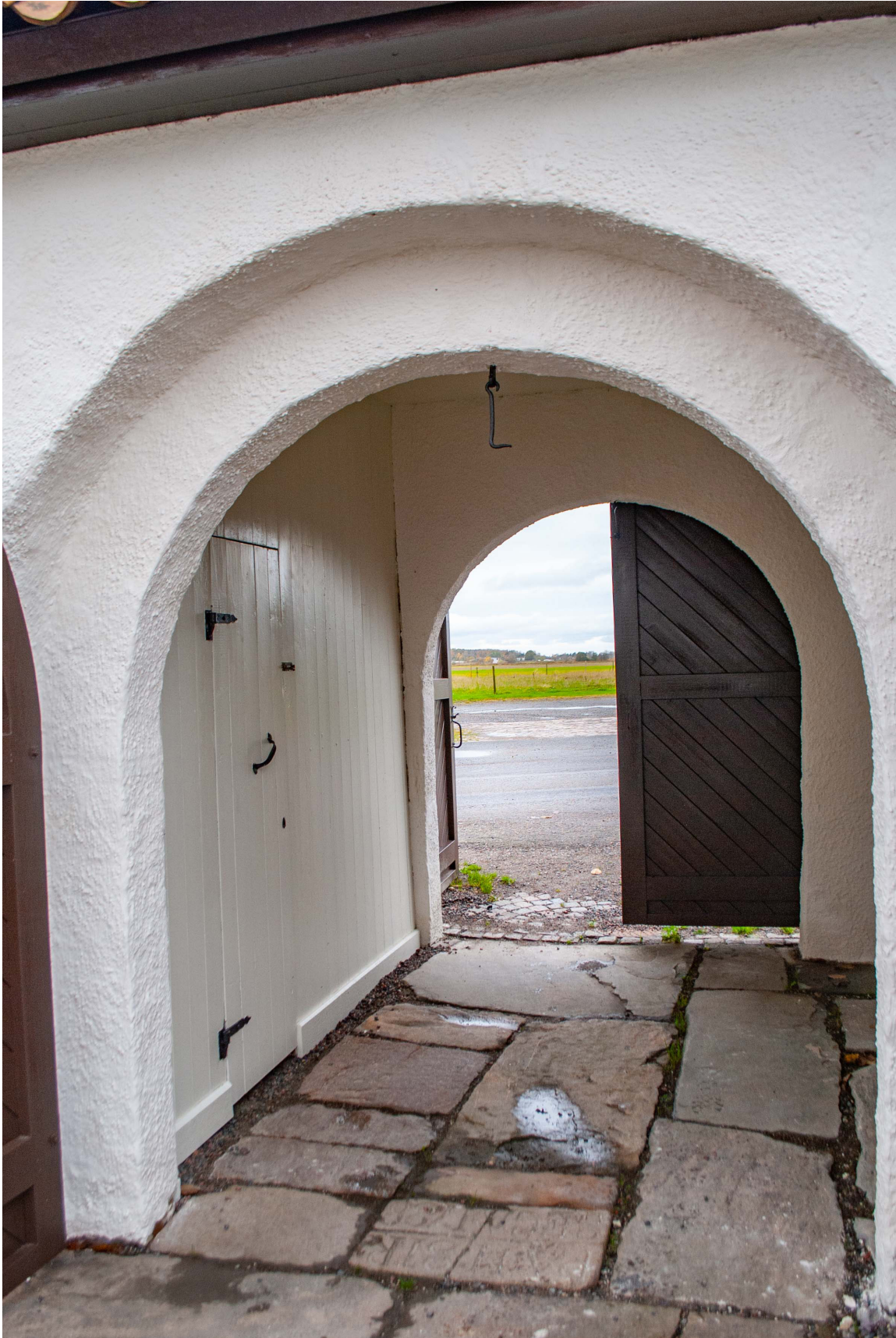
Utblick över landskapet genom den västra stigporten, vars golv är belagt med stenhällar och gamla gravvårdar.
