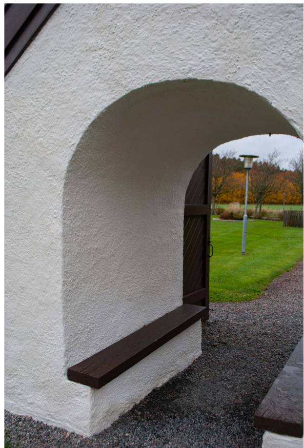
Ovan södra stigluckan och till höger den norra, efter renoveringen. Även bänkarna inne portalen är målade, med samma bruna linoljefärg som vindskivor och vattbrädor.
