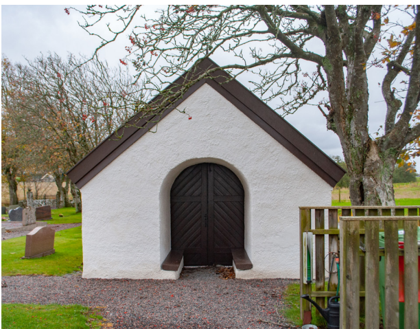
Ovan södra stigluckan och till höger den norra, efter renoveringen. Även bänkarna inne portalen är målade, med samma bruna linoljefärg som vindskivor och vattbrädor.
