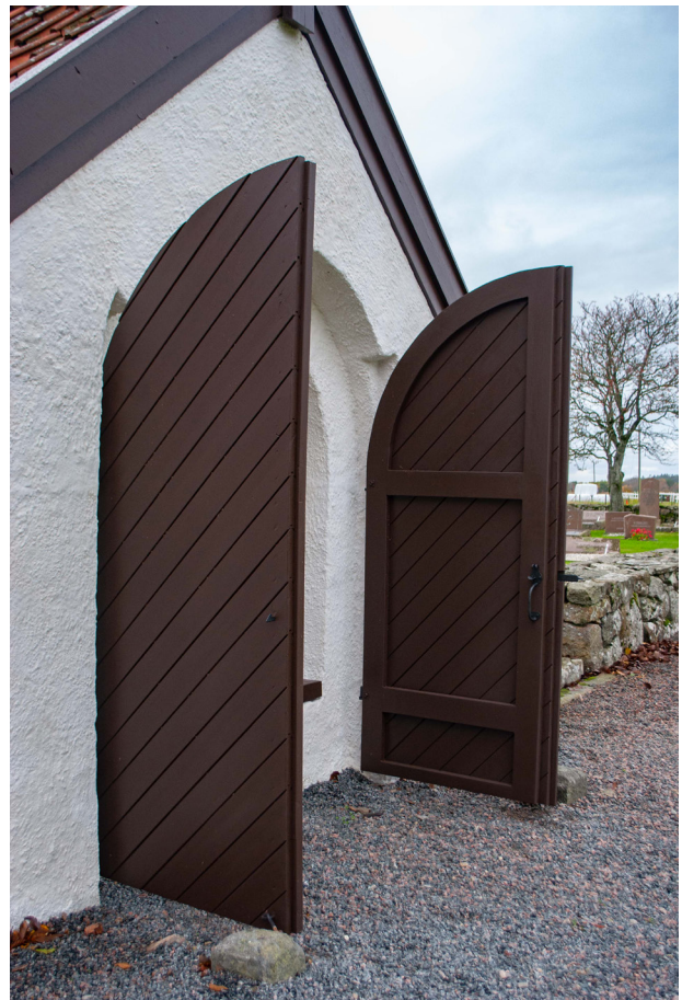
Ovan: Västporten i tornet har målats med likadan brun linoljefärg som tidigare. Till höger: Portalen på södra långhusväggen är målad i vitt som tidigare. Under tegeltaket skymtar den nymålade takfoten.
