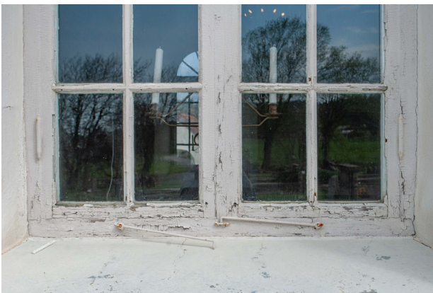
Fönstren, framför allt de mot söder, var i stort behov av renovering och ommålning. På övre fotot syns de små hål som borrats i spröjsen för att förhindra kondens mellan rutorna.
