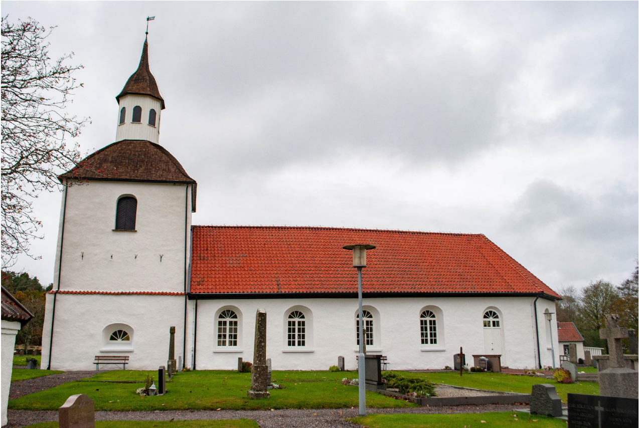
Kyrkan sedd från söder efter renoveringen. Alla fasader är lagade och målade, liksom fönster, portar, luckor och lanternin.
