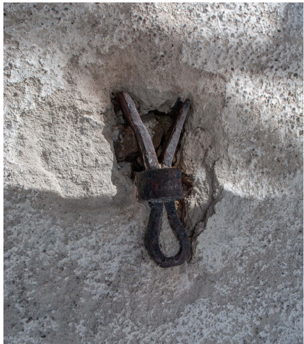
De ankarjärn, kring vilka det fanns putsskador, frilades för att kunna rostskyddsbehandlas och målas. Putsen lagades.
