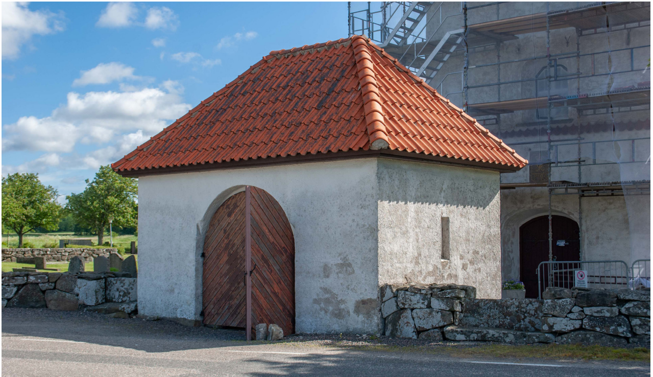
Västra stigluckan under renoveringen.
