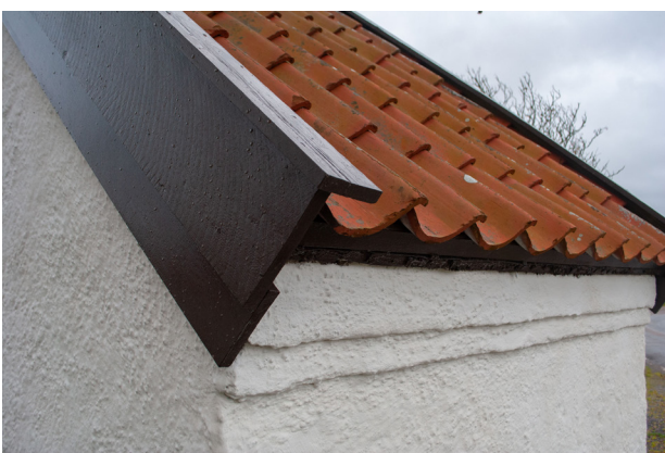
Ovan de nymålade vindskivorna och vattbrädorna på södra stigluckan. Till höger de nytillverkade portarna på den norra stigluckan.
