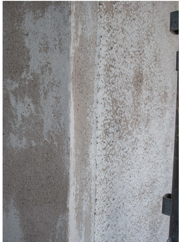
Putsade ytor på kyrka och stigportar blästrades skonsamt rena från löst material.
