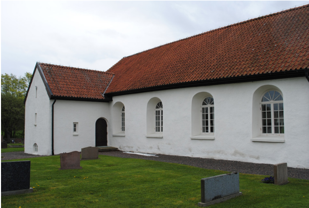
Den norra sidan var i tämligen gott skick men i behov av underhåll.
